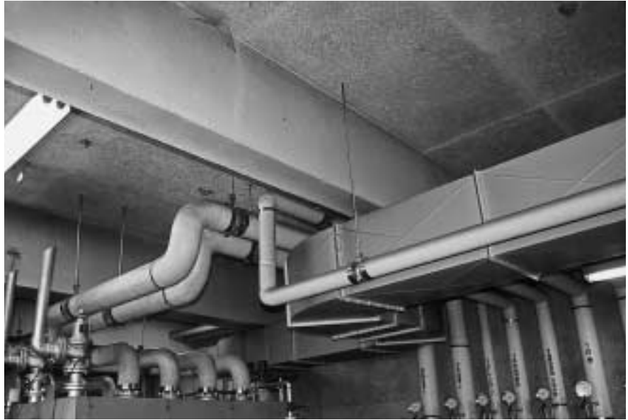
天井や壁などに使用されている建材を調査
