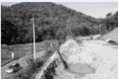
完成すれば冬道の通行が楽になります(板橋笹渡線)
