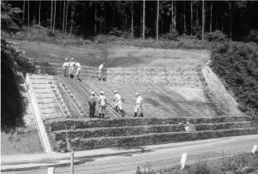
災害復旧工事を進める横田岩崎線
