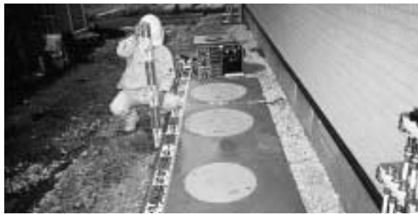
浄化槽は、町が維持管理することに
