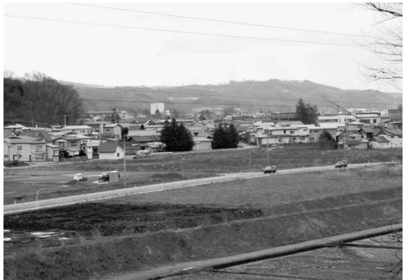
住宅団地の整備が予定される川口橋場地区
