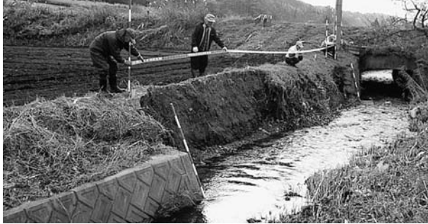
豪雨による河川の氾濫で、多くの被害が発生（平成十八年十一月、測量の様子）
