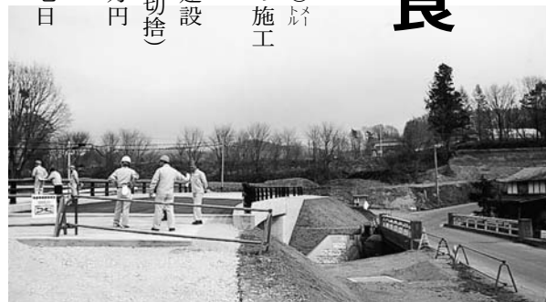
改良が進む白樫大渡線。橋の架け替えはすでに完了している。（写真）土木経済常任委員会所管事務調査 4月27日
