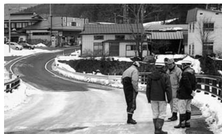
完成が待たれる白樫大渡線（12月27日 現場監査の様子）
