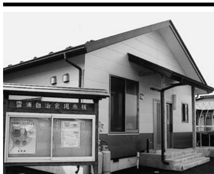
雪浦地区に完成した水稻種子生産研修施設
