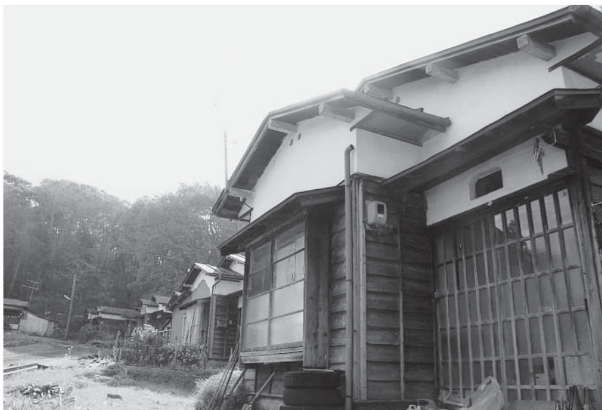
ひっそりとたたずむ子抱住宅は、現在 43 棟のうち 20 棟が空屋。老朽化による地震被害が懸念され、ことし一部解体も予定されている。
