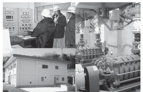
改修が進む子抱浄水場(完成検査の様子)
