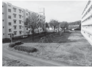
駐車場整備が予定される雇用促進住宅
