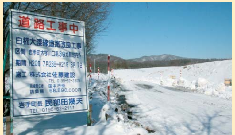
春の訪れとともに早期完成を待つ白楯大渡線道路改良工事
