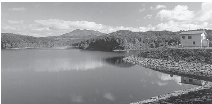
一方井土地改良事業により整備された一方井ダム
