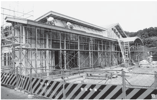
建設が進む水堀保育所
