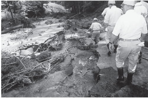
土砂で損壊した道を、恐る恐る歩いて渡る (横沢と朽木林の地区を結ぶ道路)
