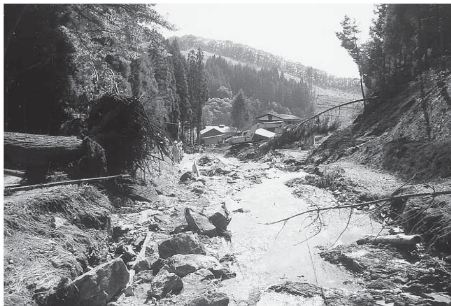
豪雨によって崩壊した横沢地区と朽木林地区を結ぶ農道（7月21日）
