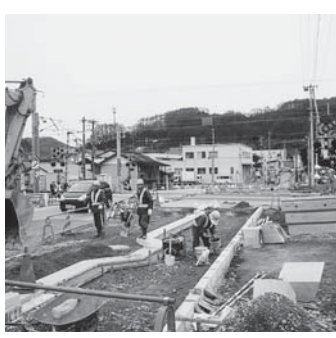
過疎対策事業債を活用して実施することとなった大宮踏切整備工事
