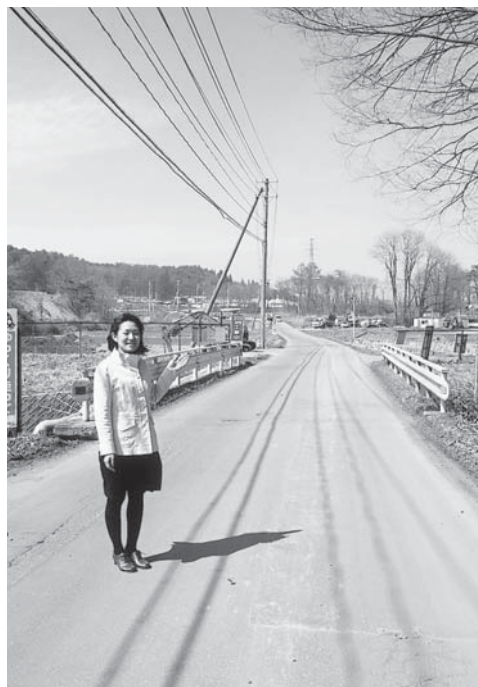
架け替えを予定する八幡橋
