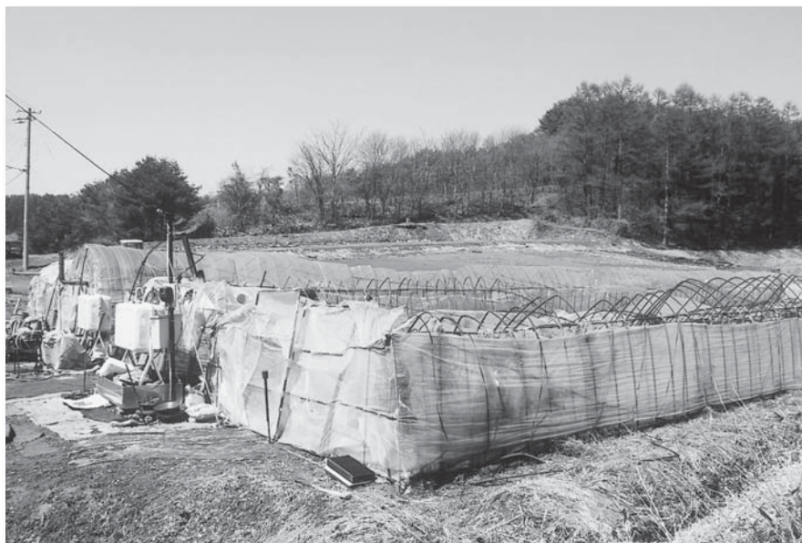
年末年始の大雪によって倒壊した園芸用パイプハウス（浮島地区）
