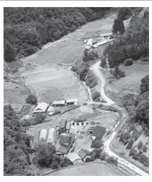
復旧工事が行われた高森地区
