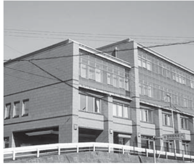
組合事務所がある岩手県自治会館
