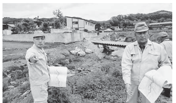
今後の復旧計画を現地で確認
