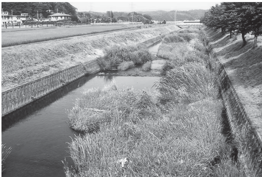
補修工事完成後、雑草が川面一帯に生い茂る一方井川
