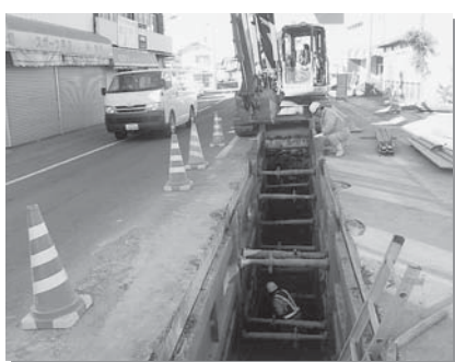
下水道整備が進む川口地区
