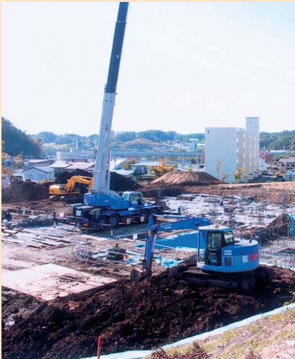
施設の建設が進む現在の様子
